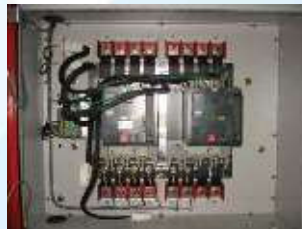
4P MCCB ATS c/w E&M Interlock Device
